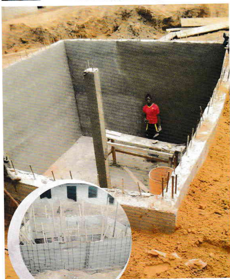
Regenwaterput in aanbouw in C.S. d'Excellence in Lodja.
