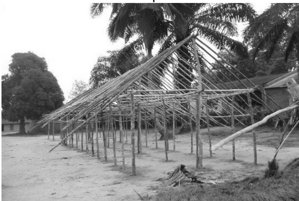
Geraamte van een klas met lemen muren en strooien dak in een school in Lodja.
